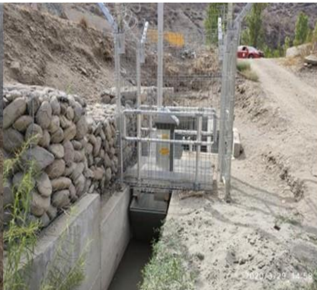
Foto 2. Canal Zamora o Las Vizcachas.
